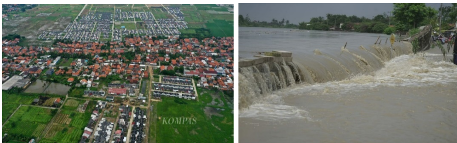
Gambar 1. Perkembangan lokasi perumahan tidak terkendali dan mengabaikan ruang resapan air sehingga memicu terjadi banjir (RODHI, 2024).
