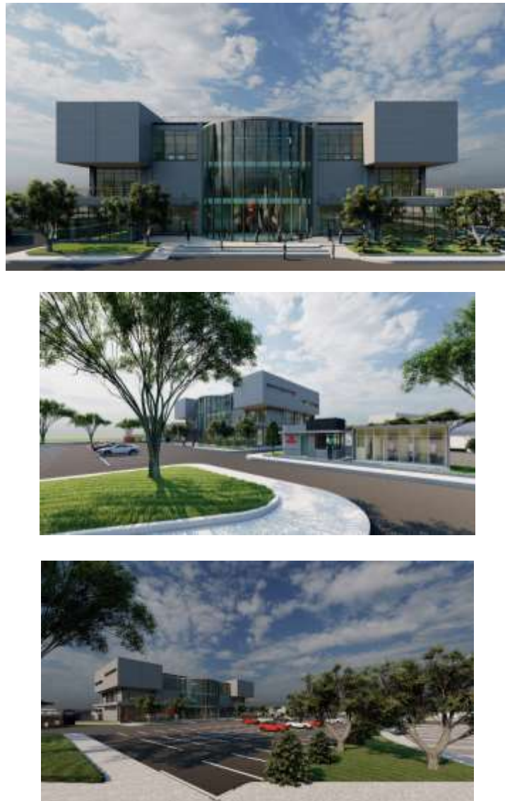
Gambar 20 Eksterior Bangunan Sumber: milik pribadi tahun 2021
